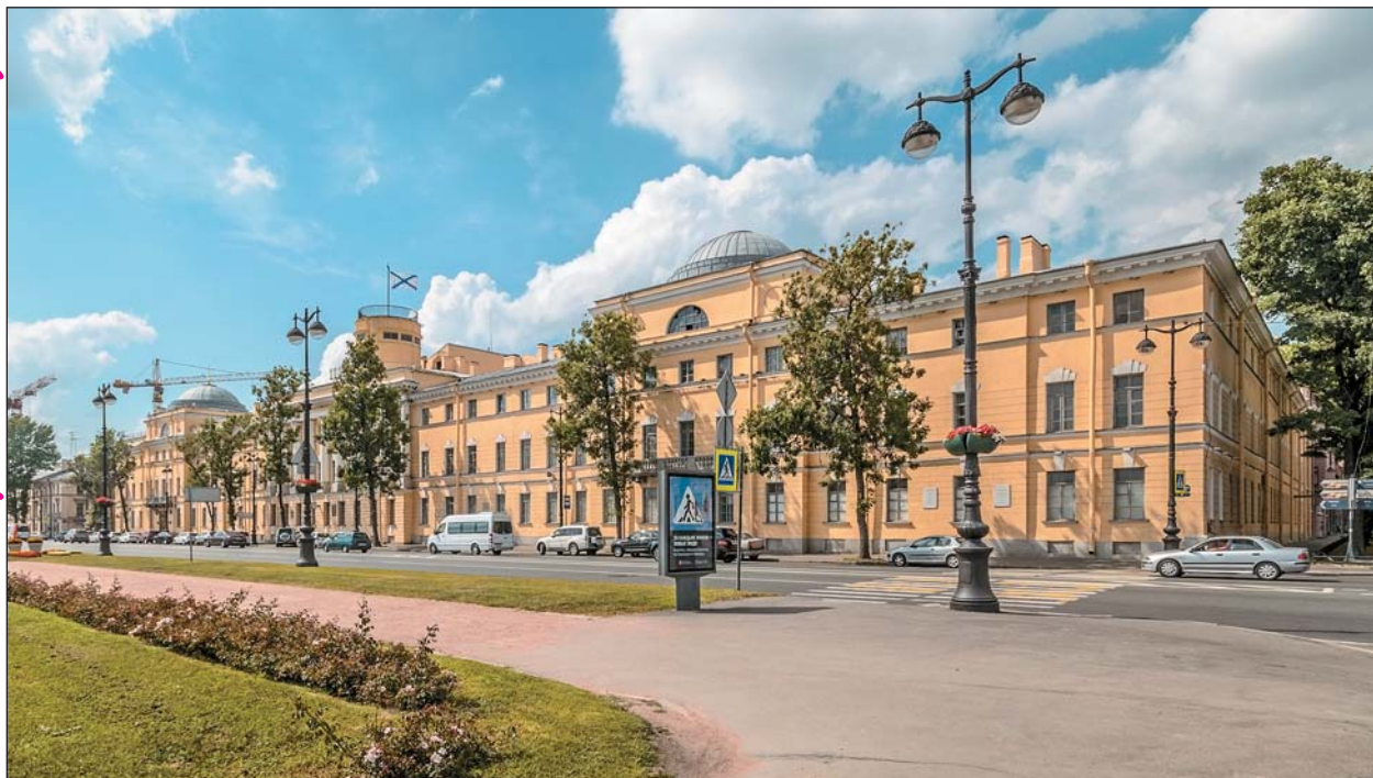
Здание Морского кадетского корпуса в Санкт-Петербурге.
